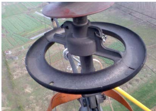
图 4 均压环反装及安装位置错误图
