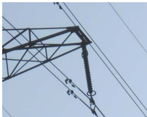
图 8 220kV 石金线线路上均压环掉落图
