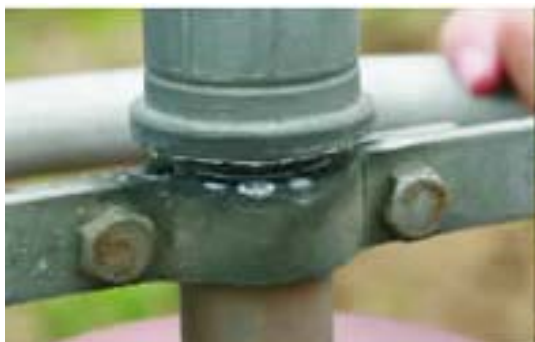
图 5 均压环安装位置错误图
