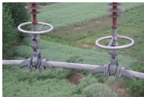
图 7 典型的均压环反装图
