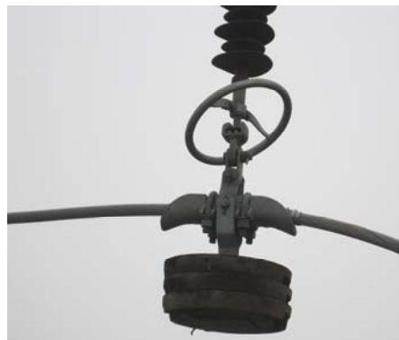
图 3 110kV 索普线跳线均压环跳线歪斜并反装
